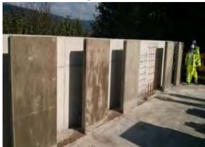
شکل ۲- بتن خودترمیم شونده
