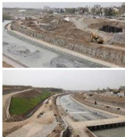
شکل ۷- تخریب ساحل شنی و تبدیل سطوح نفوذپذیر رود
