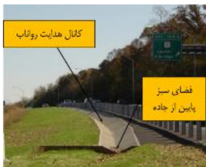
شکل ۱۰- چمن‌ها و سطوح نفوذپذیر در سطحی پایین‌تر از سطوح غیرقابل نفوذ، عامل مهمی در کنترل سیلاب‌های شهری (Davis, James H, Jamil, & Kim, 2012)
