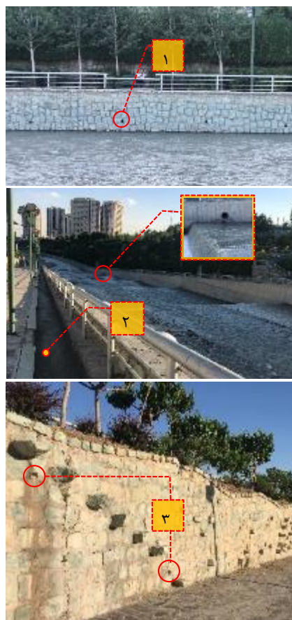
شکل ۹- سیستم زهکشی و هدایت آب: (۱) تخلیه و هدایت آب‌های سطحی بوستان از طریق سیستم زهکشی به رودخانه‌ی کن (۲) جمع‌آوری و هدایت آب پیاده‌رو از طریق جوی (۳) هدایت آب اضافی باغچه‌ها و سطوح بالاتر به پیاده‌روی جنب رود (نگارندگان)
