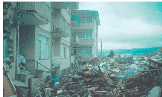
شکل ۶. تخریب ساختمان‌ها در اثر گسلش سطحی (Bray, 1994, Lazarte &)
