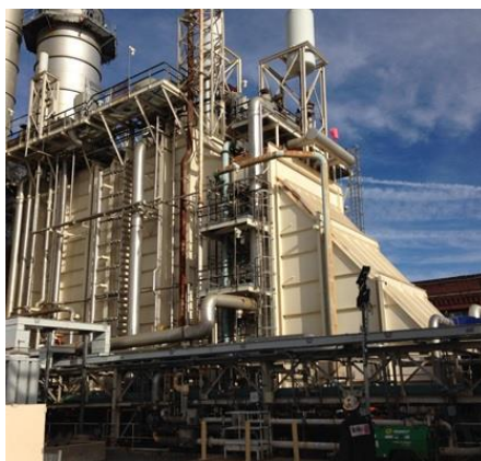
شکل ۱: نمونه‌ای از بویلر بازیاب حرارت عمودی و دودکش یکپارچه شده با آن
