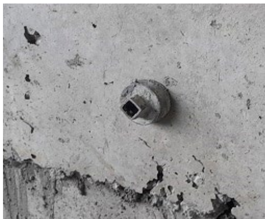
ب: چسباندن استوانه روی سطح بتن
